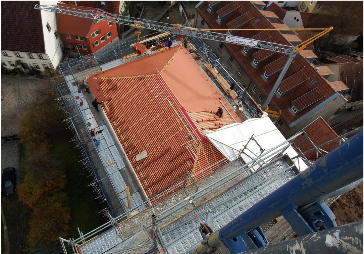
Das Kirchenschiff vom Turmgerüst aus gesehen:
