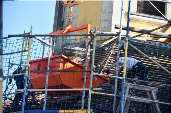
9. Mai 2020: Beginn Zimmererarbeiten
